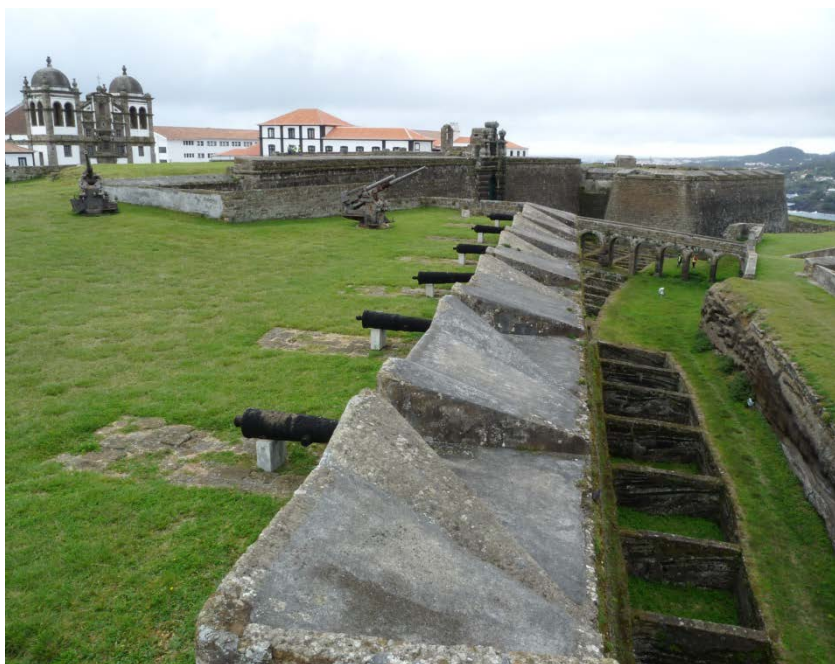
Figura 10. Detalle de las cañoneras, la escarpa, los baluartes, el foso con las covas de lobo, la contraescarpa y el camino cubierto del fuerte o castillo de São João Batista en Angra do Heroísmo. A la izquierda de la imagen, emergen las torres y la fachada de la iglesia del fuerte, ya erigida tras la Restauração monárquica en Portugal.
