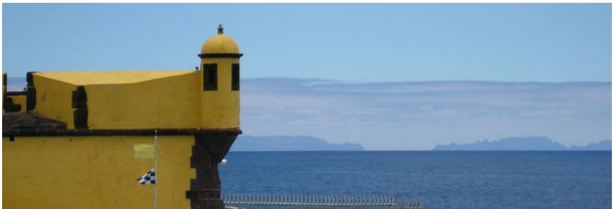
Figura 19. Detalle de una cañonera, un merlón y una garita del fuerte de São Tiago de Funchal. Al fondo se percibe el perfil de las islas desiertas.
