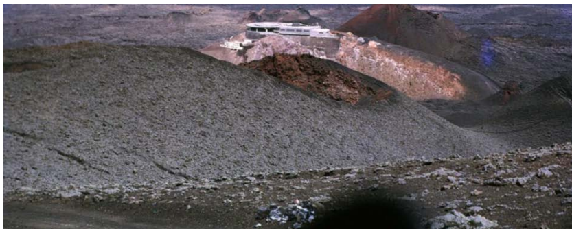
El Centro de Arte durante la construcción.
