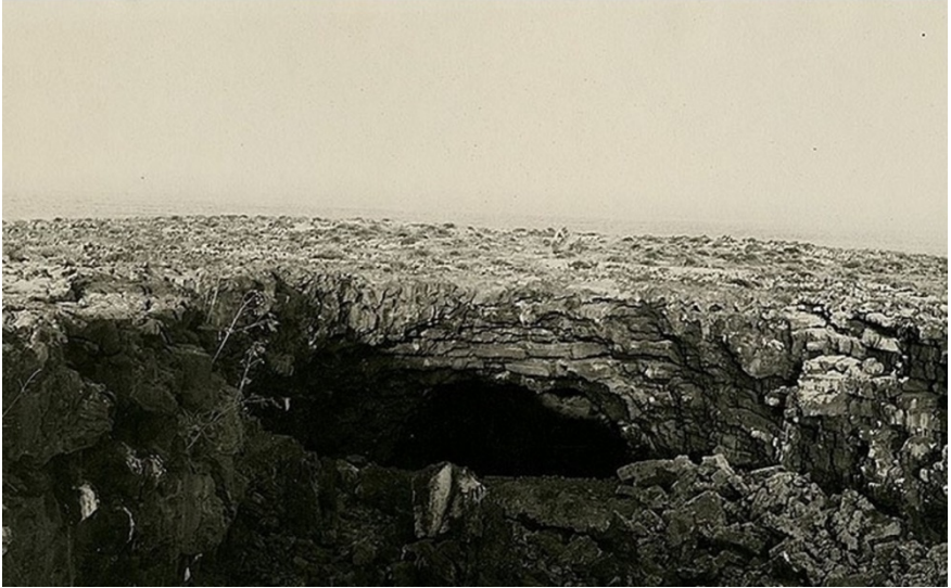
El Jameo Chico antes de la intervención de César Manrique.
