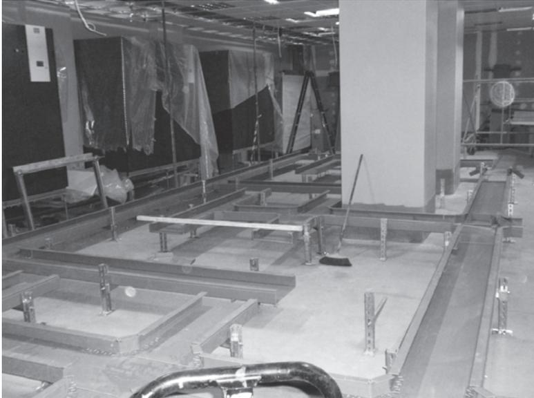
*- Instalación de las bandejas de cableado de datos y eléctricos -*
