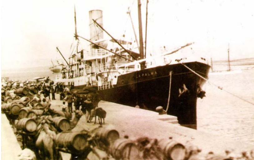
DESCARGA DE AGUA DEL CORREÍLLO.
