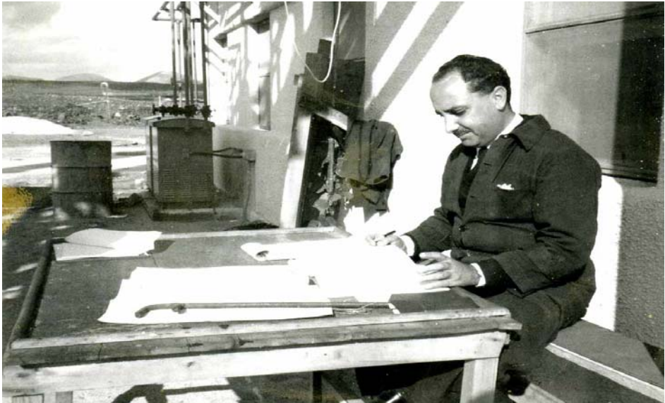
SEGUIMIENTO DEL MONTAJE.
